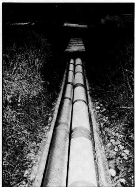
*Dobro izoliranim cjevovodom (relativno) topla voda iz bazena odvodi se do izmjenjivača topline i toplinske crpke kako bi u hladnim mjesecima zagrijavala cijelu kuću.*
